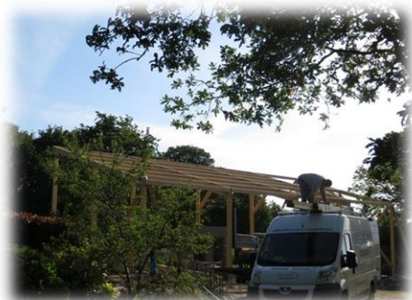
Travaux atelier municipal
