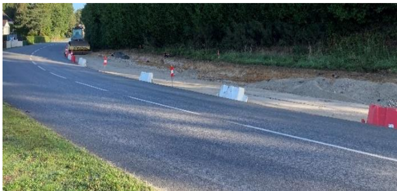
Pont-Saint-Fiacre réaménagement du virage sur la D11
