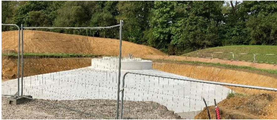
Le chantier de construction de notre 5 ème éolienne arrive à sa phase de montage, les fondations viennent d'être accomplies.
